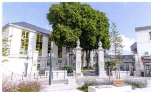
En plein centre-ville de Châteauroux l'EICMI occupe un bâtiment de 2 500 m 2 .
